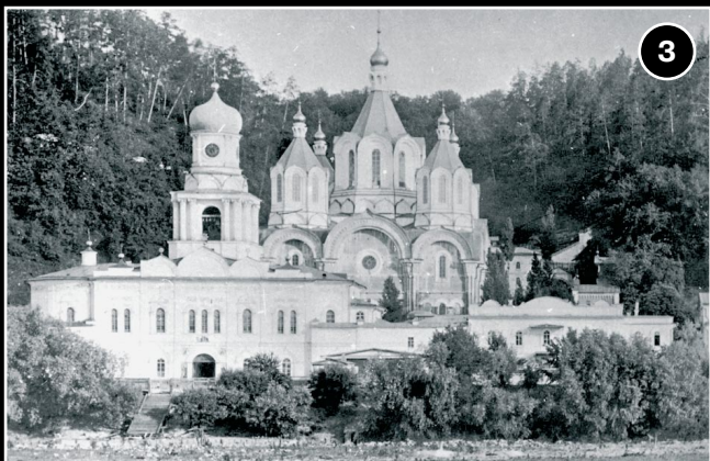
Покровская церковь с колокольней. Фото XIX в.
