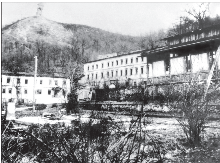
Здание гостиницевого двора XIX века, фото 1943 года
