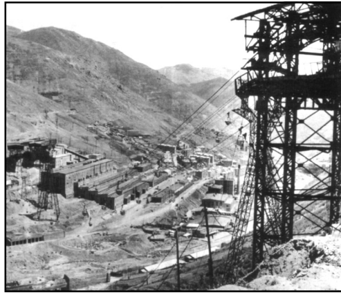
Рис. 1. Вірменія. Зангезурський мідно-молібденовий комбінат у 70-і роки ХХ ст. На передньому плані 90-метрова опора канатної дороги, яка транспортує руду з кар'єра на збагачувальну фабрику
