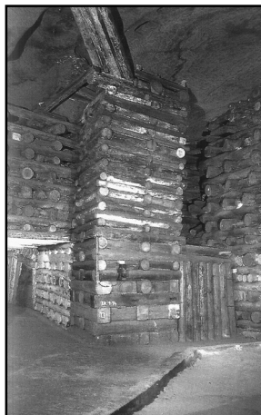
Рис. 6. Польща. Клітвове кріплення (шахта Велічка)
