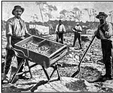
Рис. 3. Австралія. Сухе збагачення золотоносного піску в Західній Австралії (90-і роки XIX ст.)
