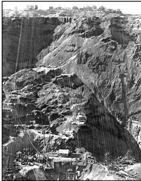
Рис. 2. ПАР. Котлованна розробка кімберлітової трубки (фото 1880 р.)
