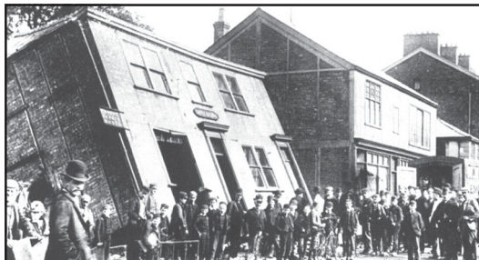
Рис. 1. Чилі. Осідання поверхні міста від гірничих робіт
